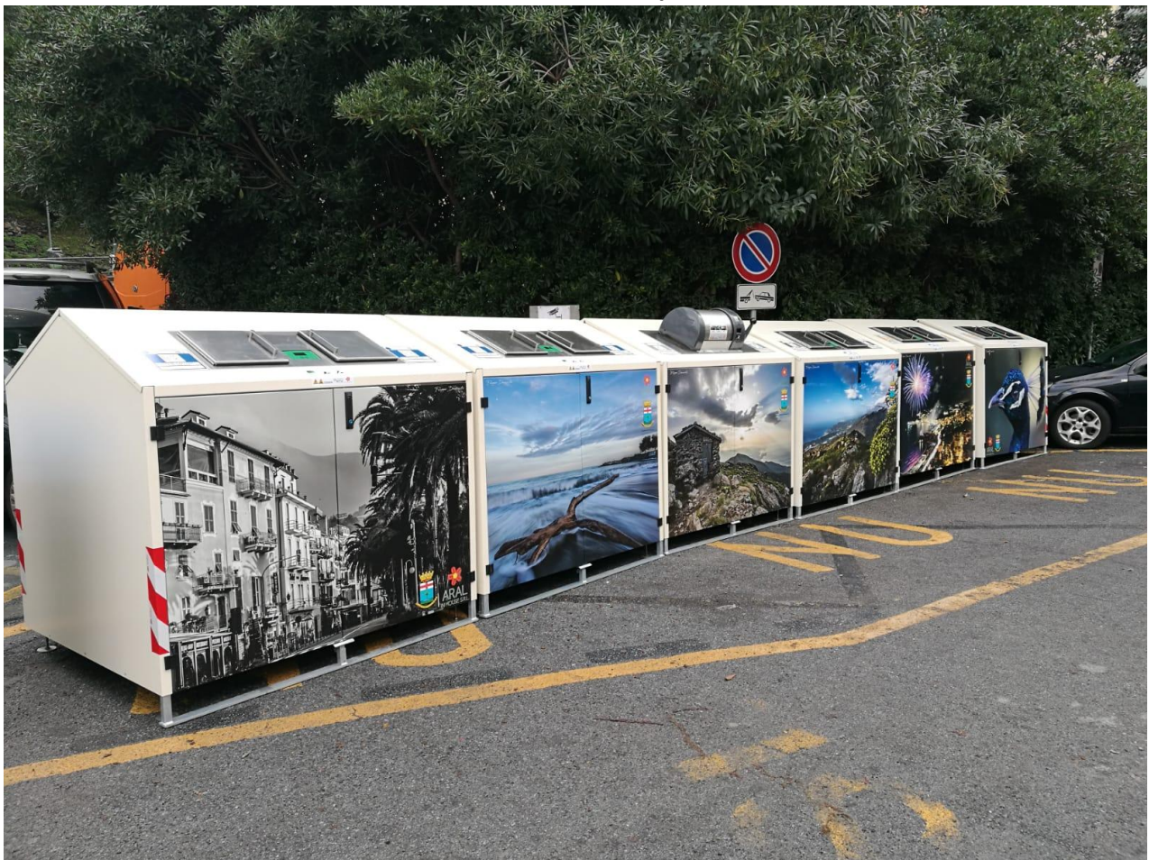
Esempio di sistema di videosorveglianza mobile autoalimentato ed interconnesso.
